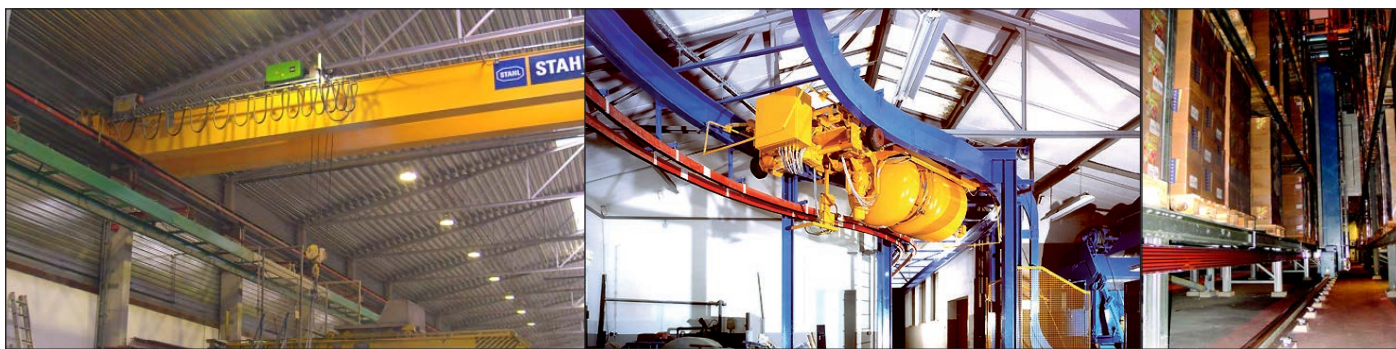
Strømtilførsel til STAHL traverskran i betonelement fabrik.
